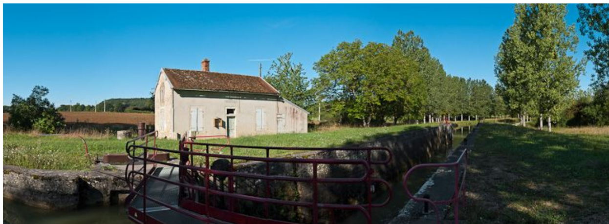
Vue d'ensemble du site d'écluse.
