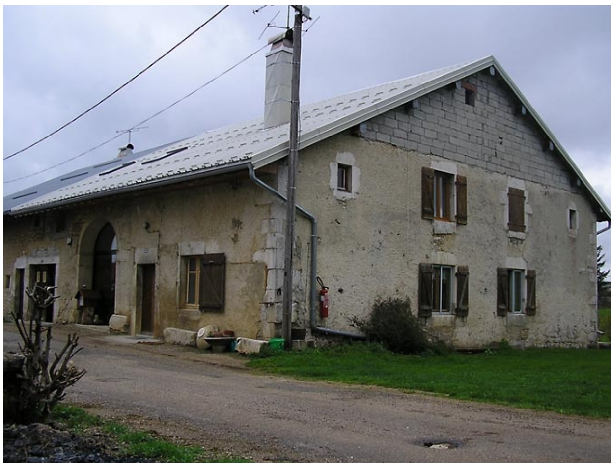
Ferme située au lieu-dit Le Coin d'Aval.
