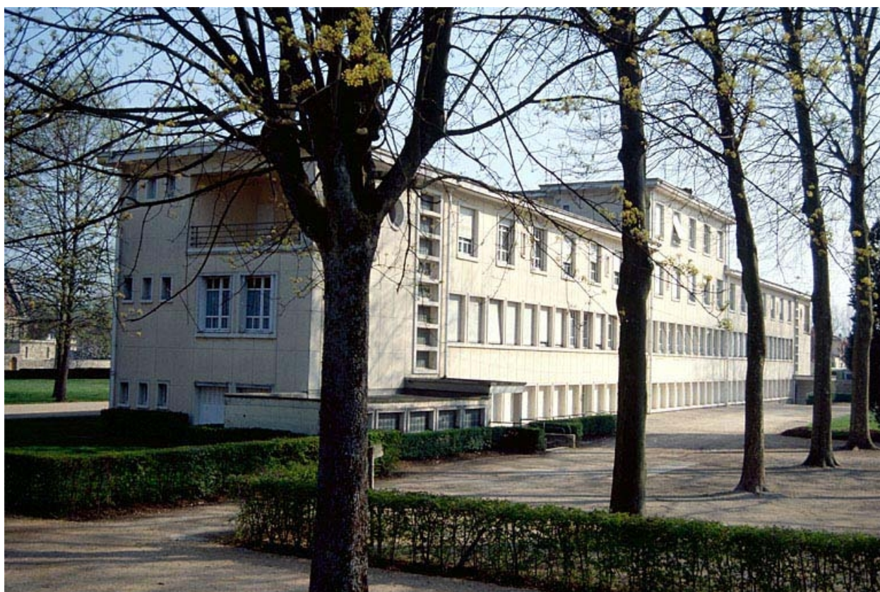
Façade postérieure et face droite.
