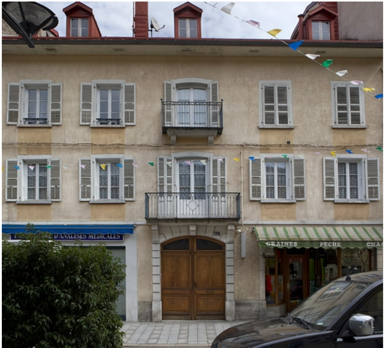
Vue d'ensemble de la façade antérieure.
