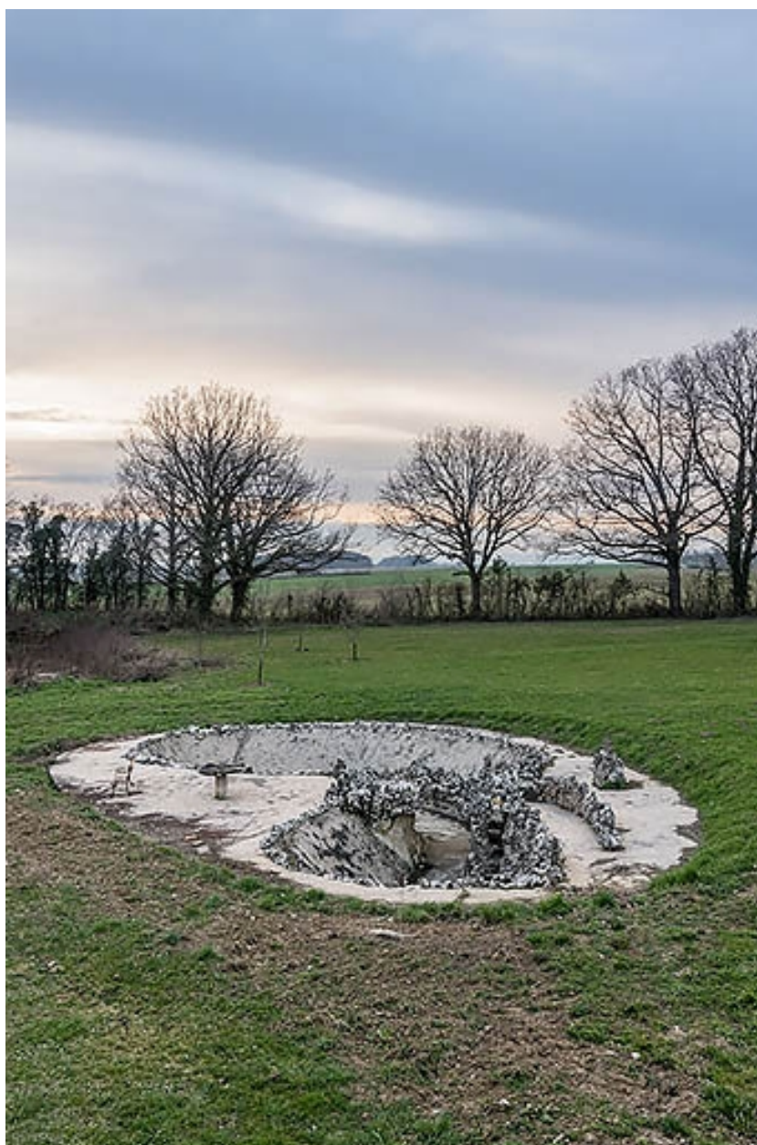
Parc : bassin avec son pont en rocaille.
