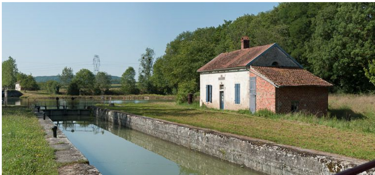
Vue d'ensemble du site d'écluse.
