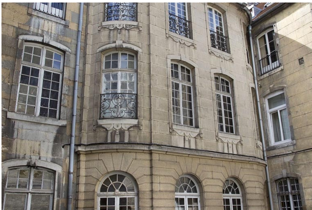
Aile de l'escalier : détail du premier étage.
