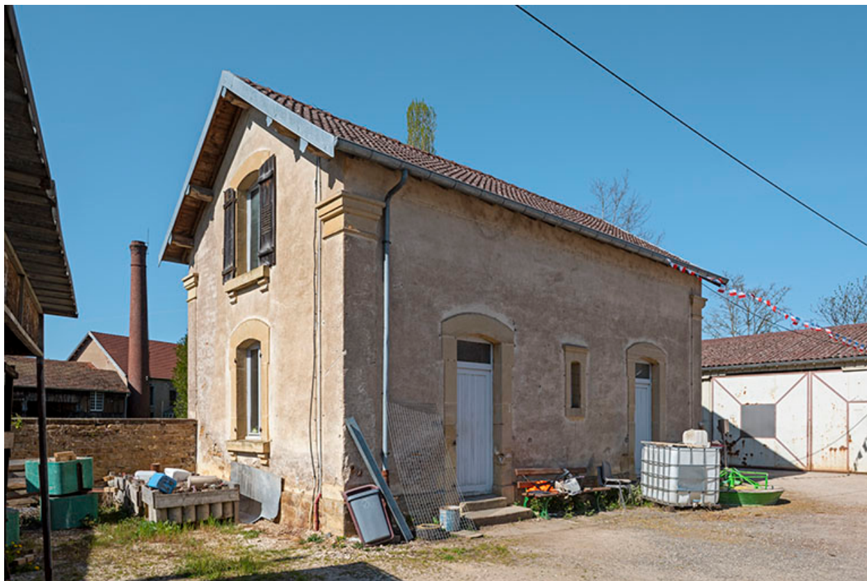
Le bâtiment occidental.
