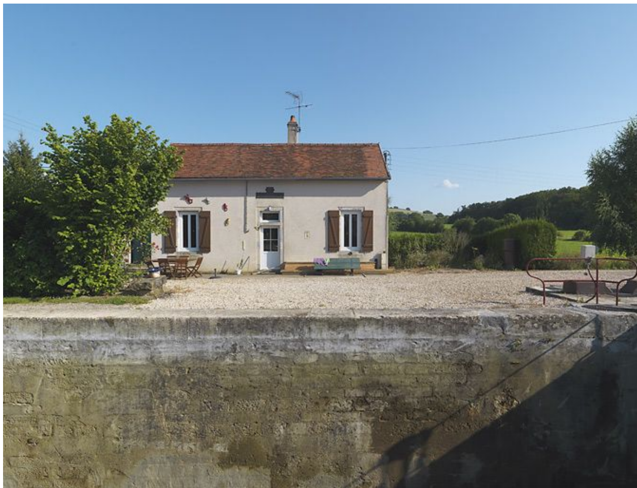
La maison éclusière.
