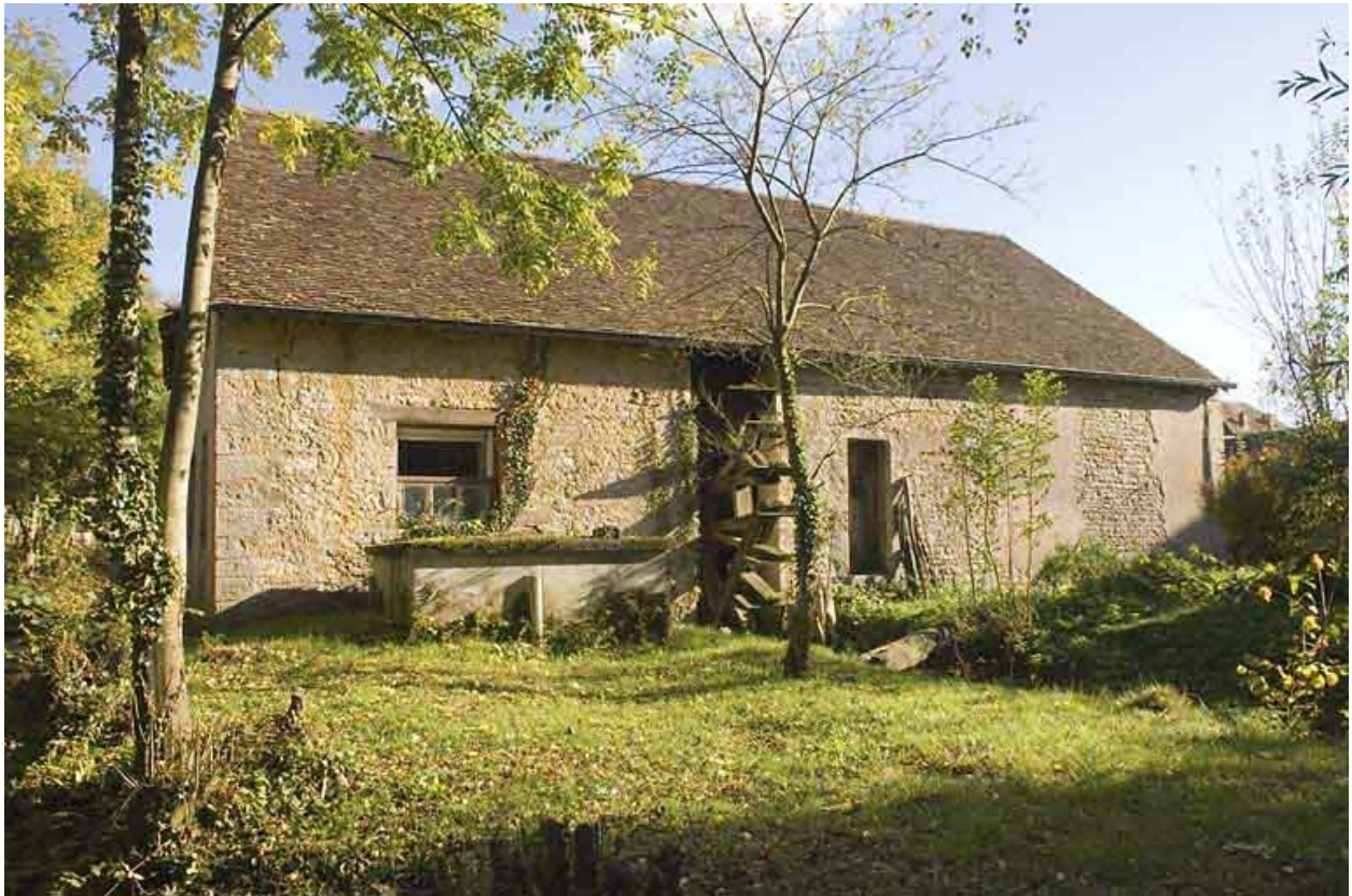
Façade postérieure du moulin.
