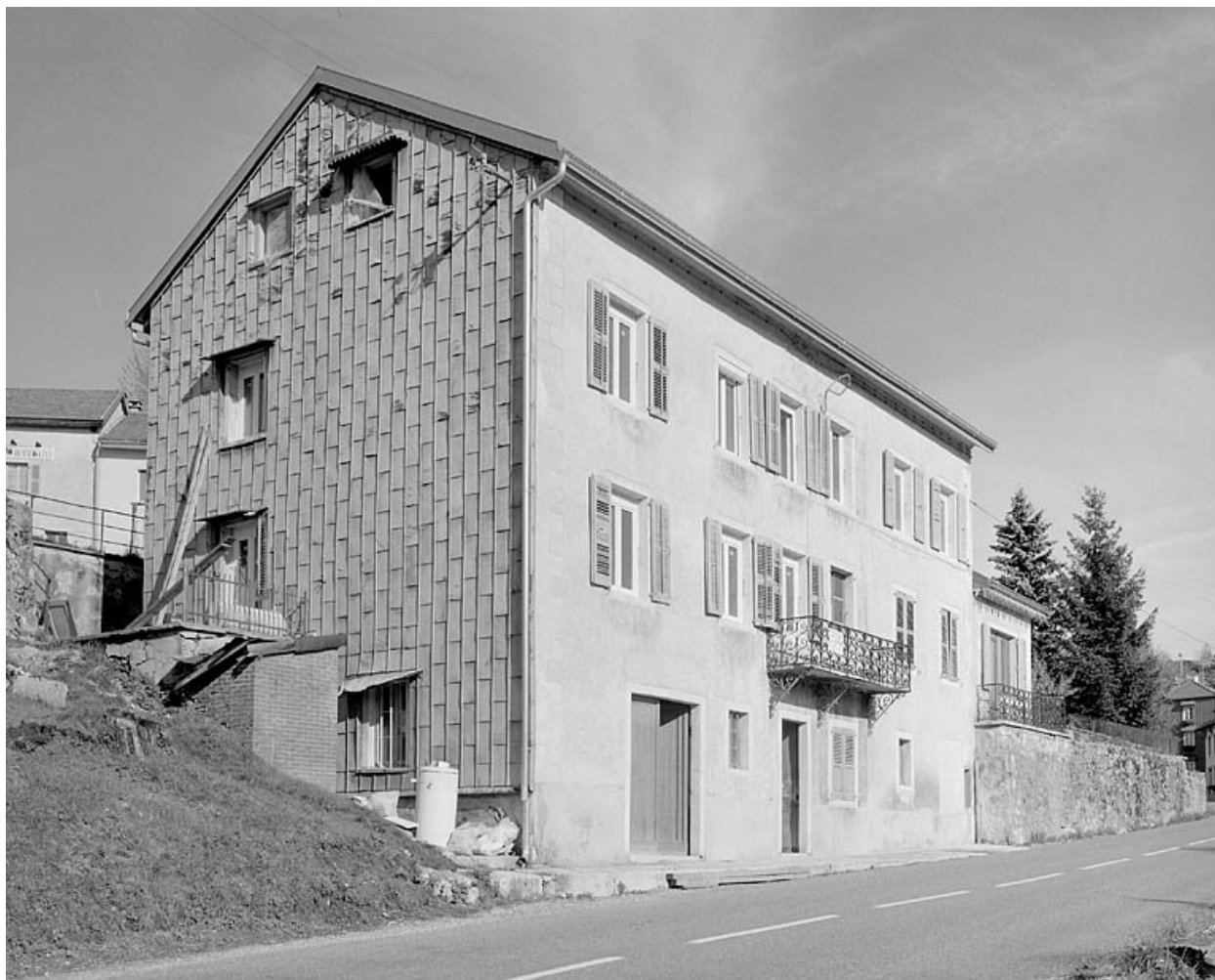
Façade antérieure et face sud-ouest.
