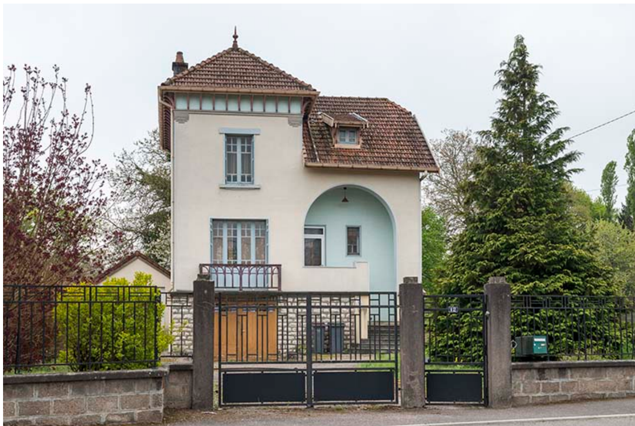
Vue générale depuis la rue du Tertre.
