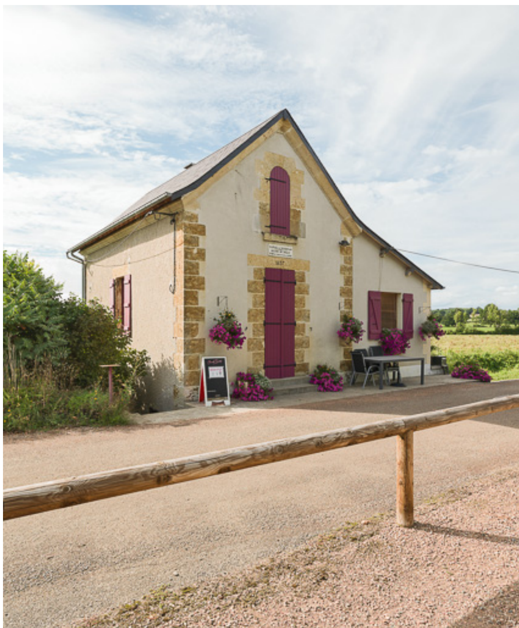
Vue de la maison éclusière.
