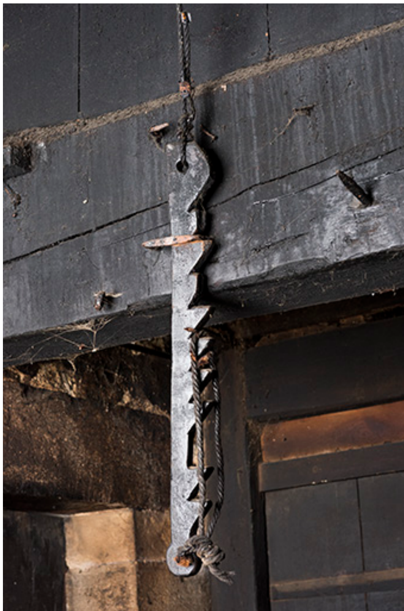
Grand tué : système de fermeture des volets.
