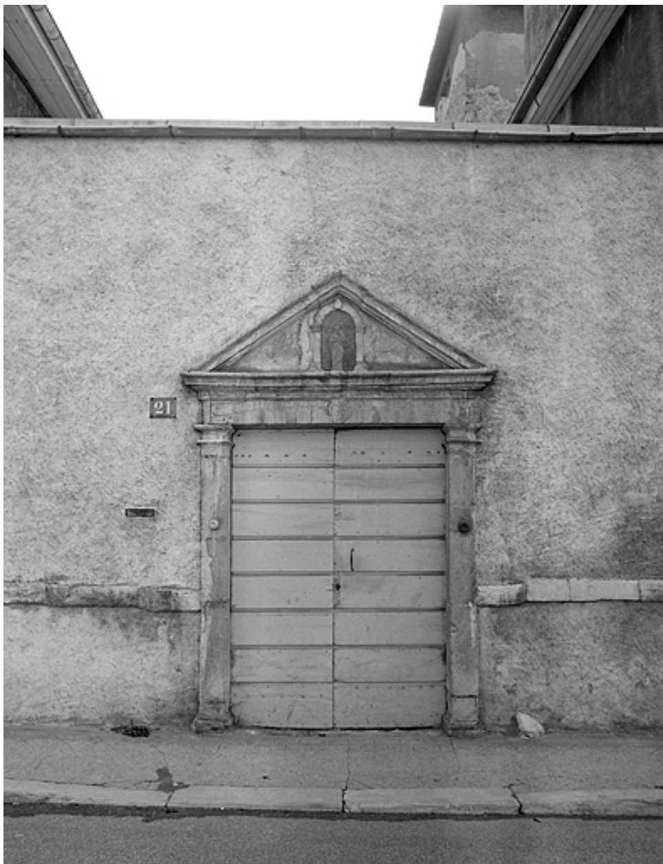
Façade antérieure, porte d'entrée.
