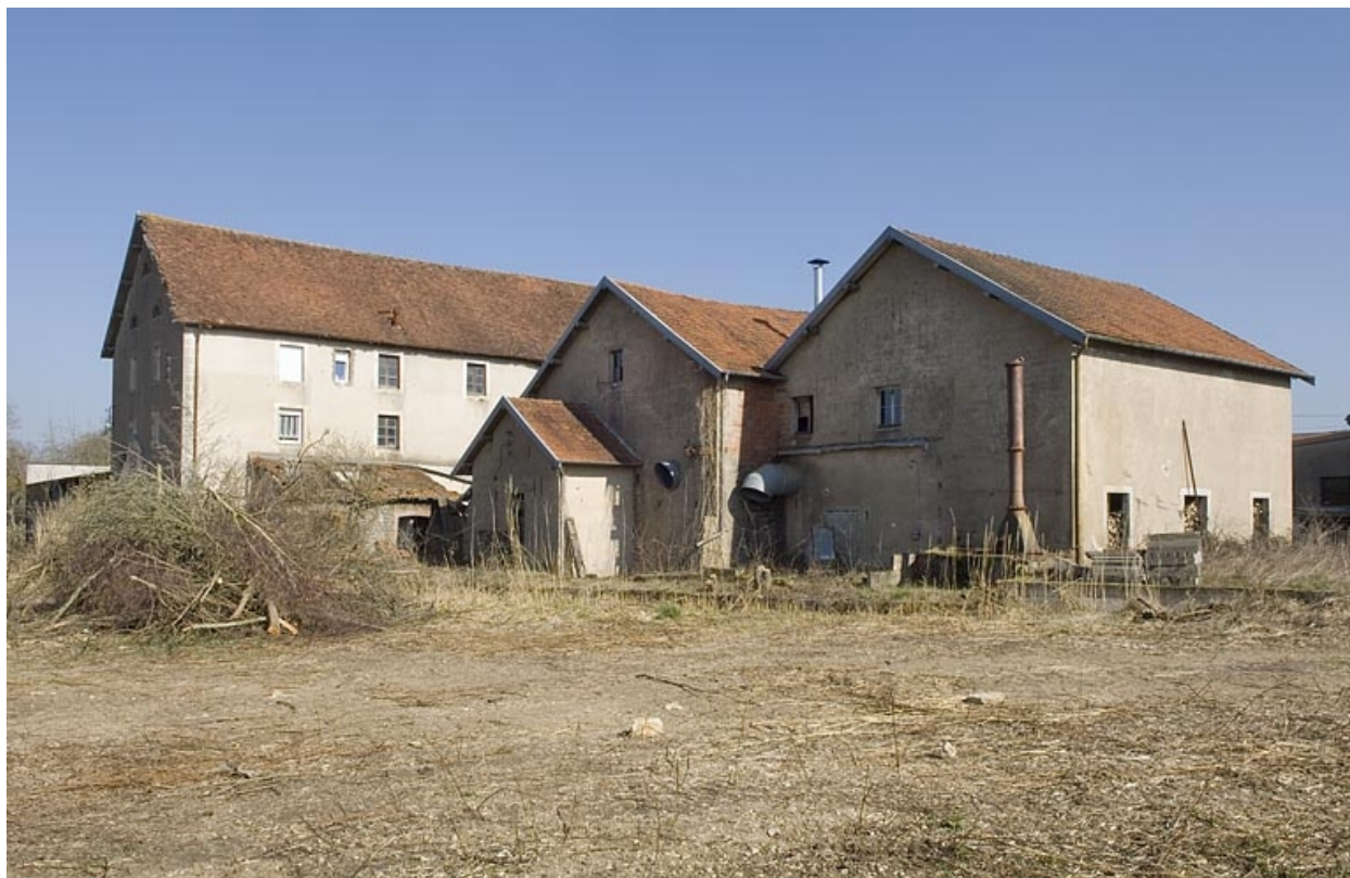
Vue d'ensemble depuis le sud.
