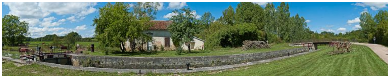
Vue d'ensemble du site d'écluse.
