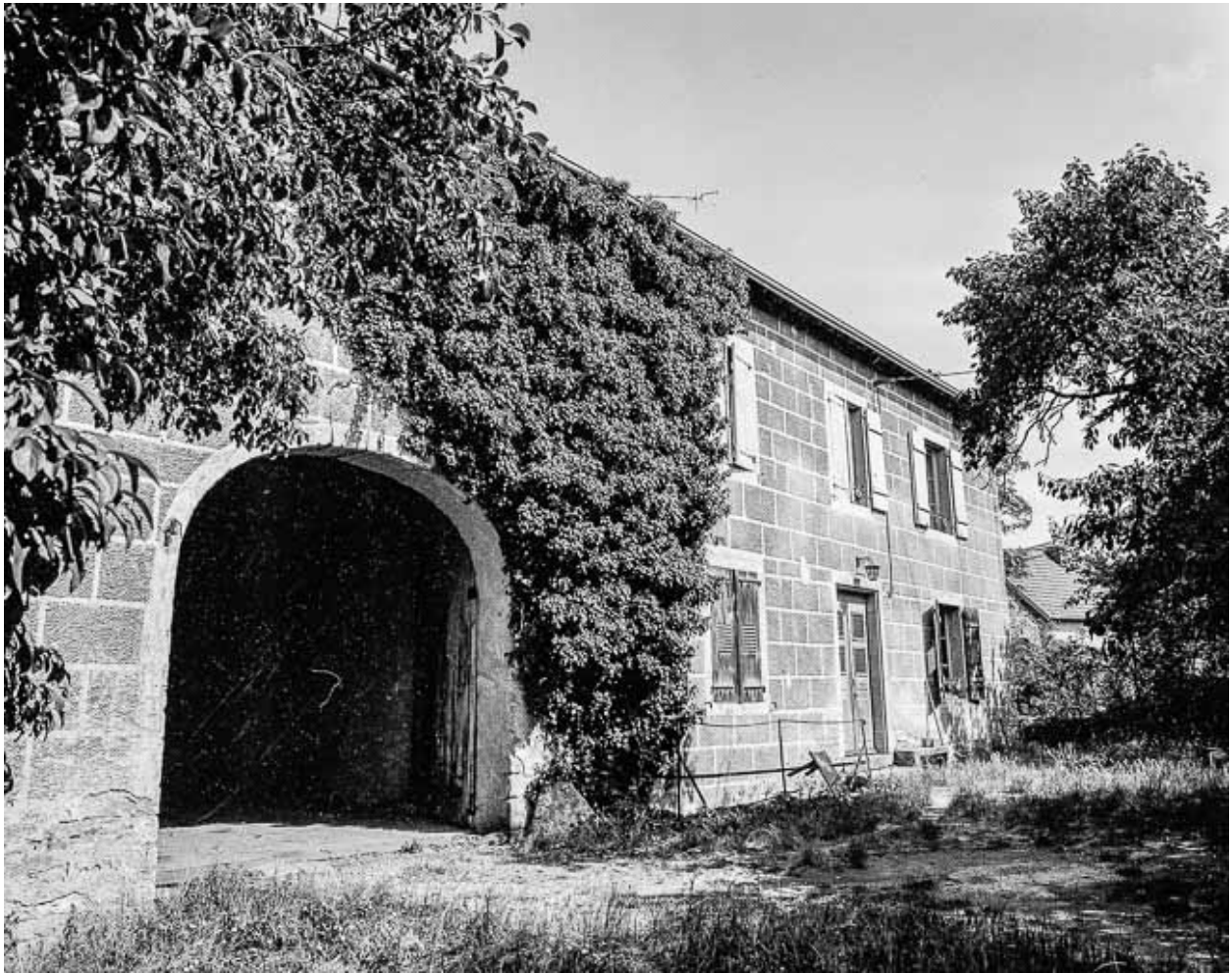
Ferme cadastrée 1973 AB 107, située rue de Montbozon : façade antérieure.
