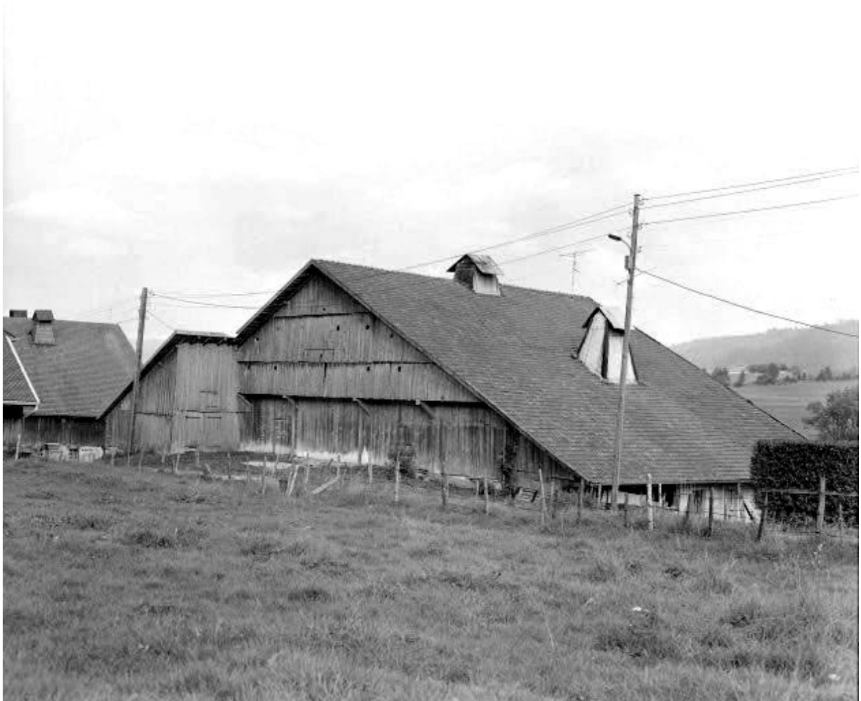
Façade ouest en 1976, de trois quarts droite.
