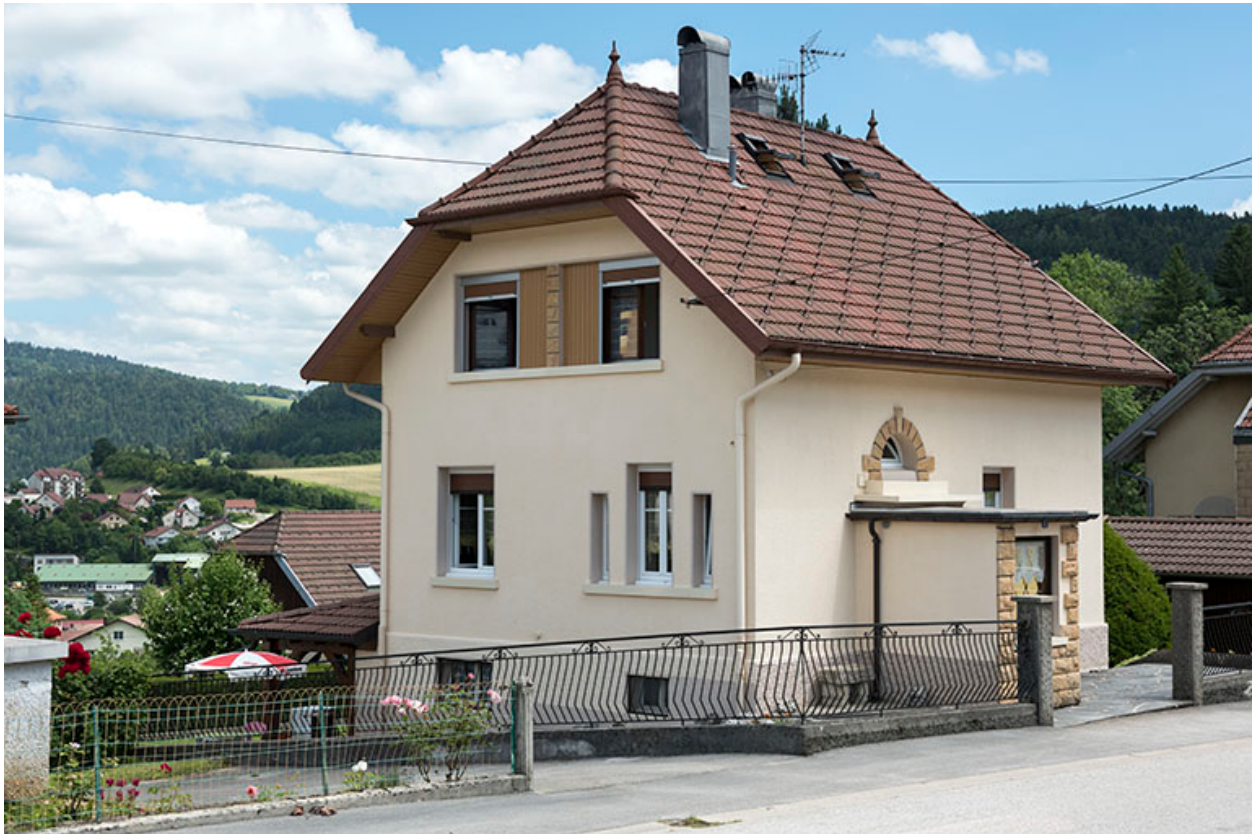
Façades antérieure et latérale gauche.
