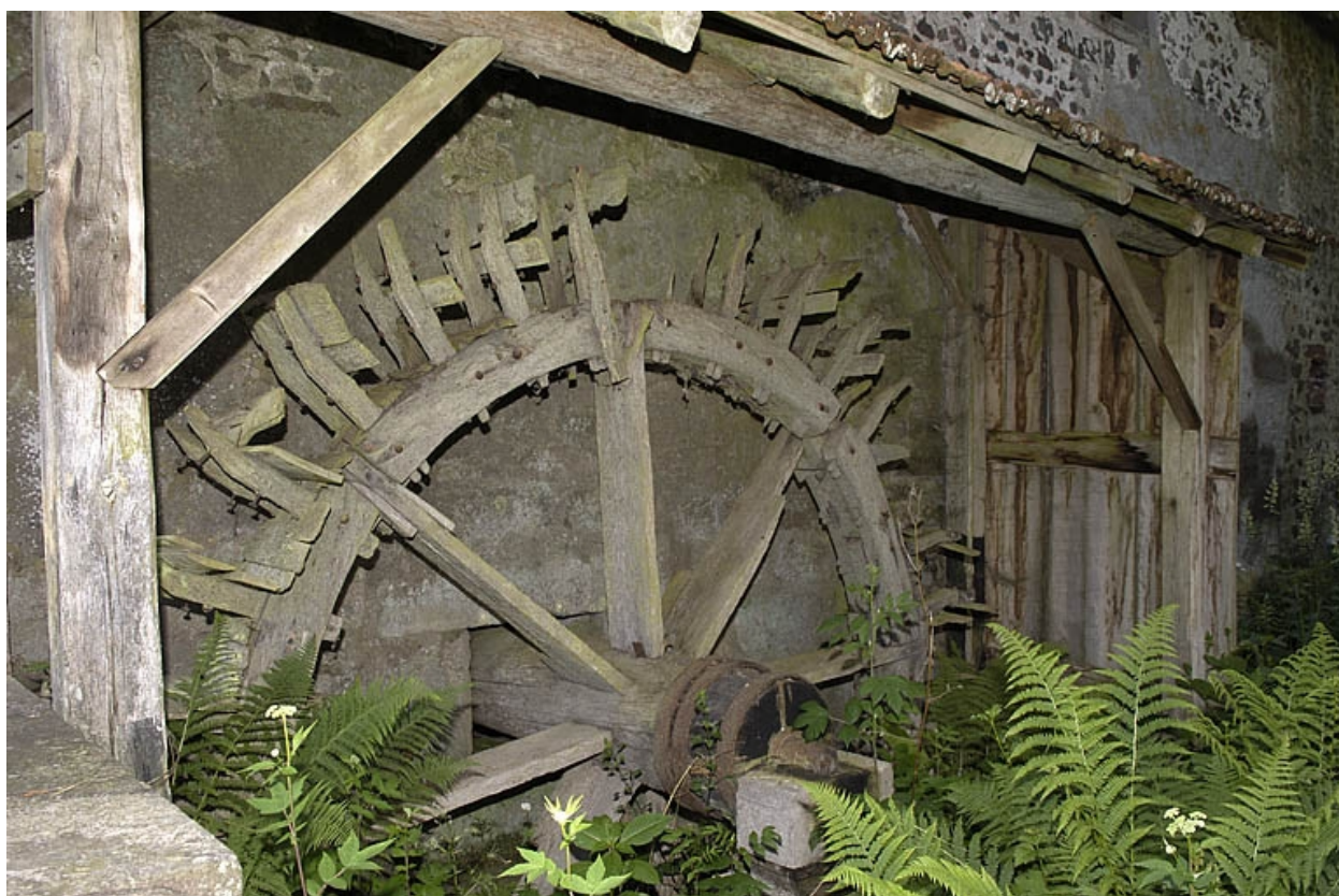
Détail de la roue hydraulique en dessous.
