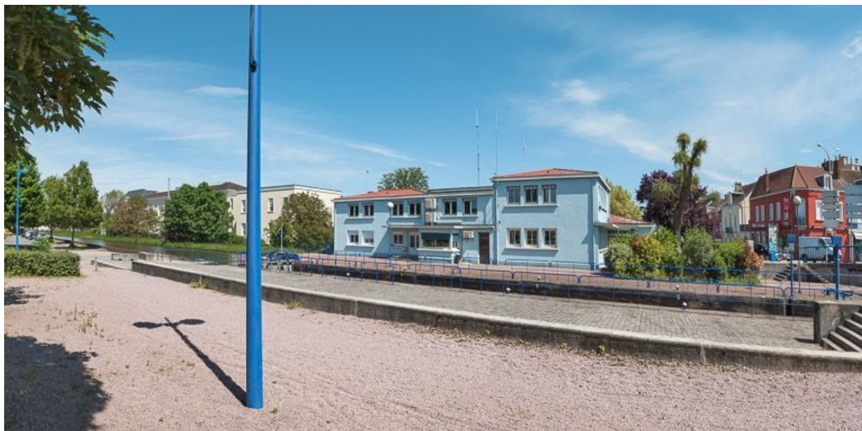
La subdivision de Montceau-les-Mines.
