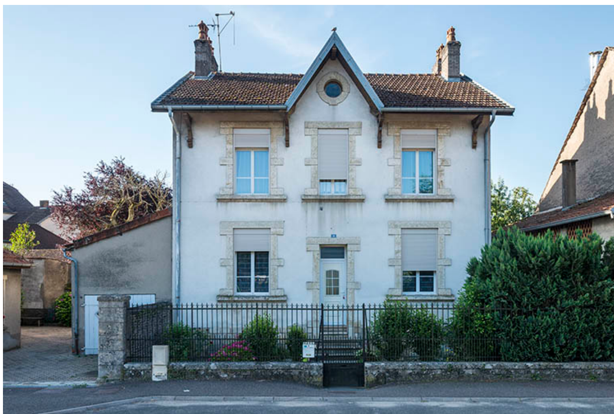
Maison n° 10, vue de face.
