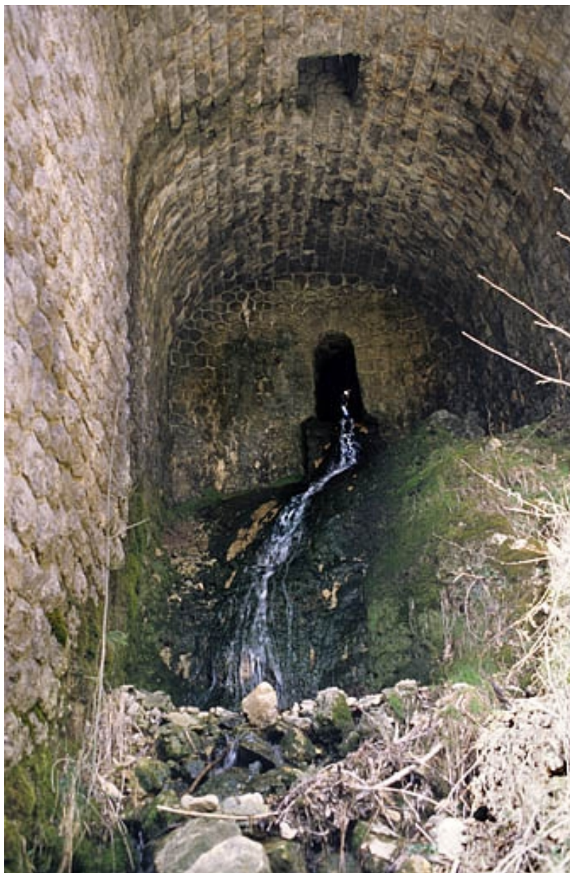
Mur de soutènement de la route : aqueduc, dans l'arche centrale.
