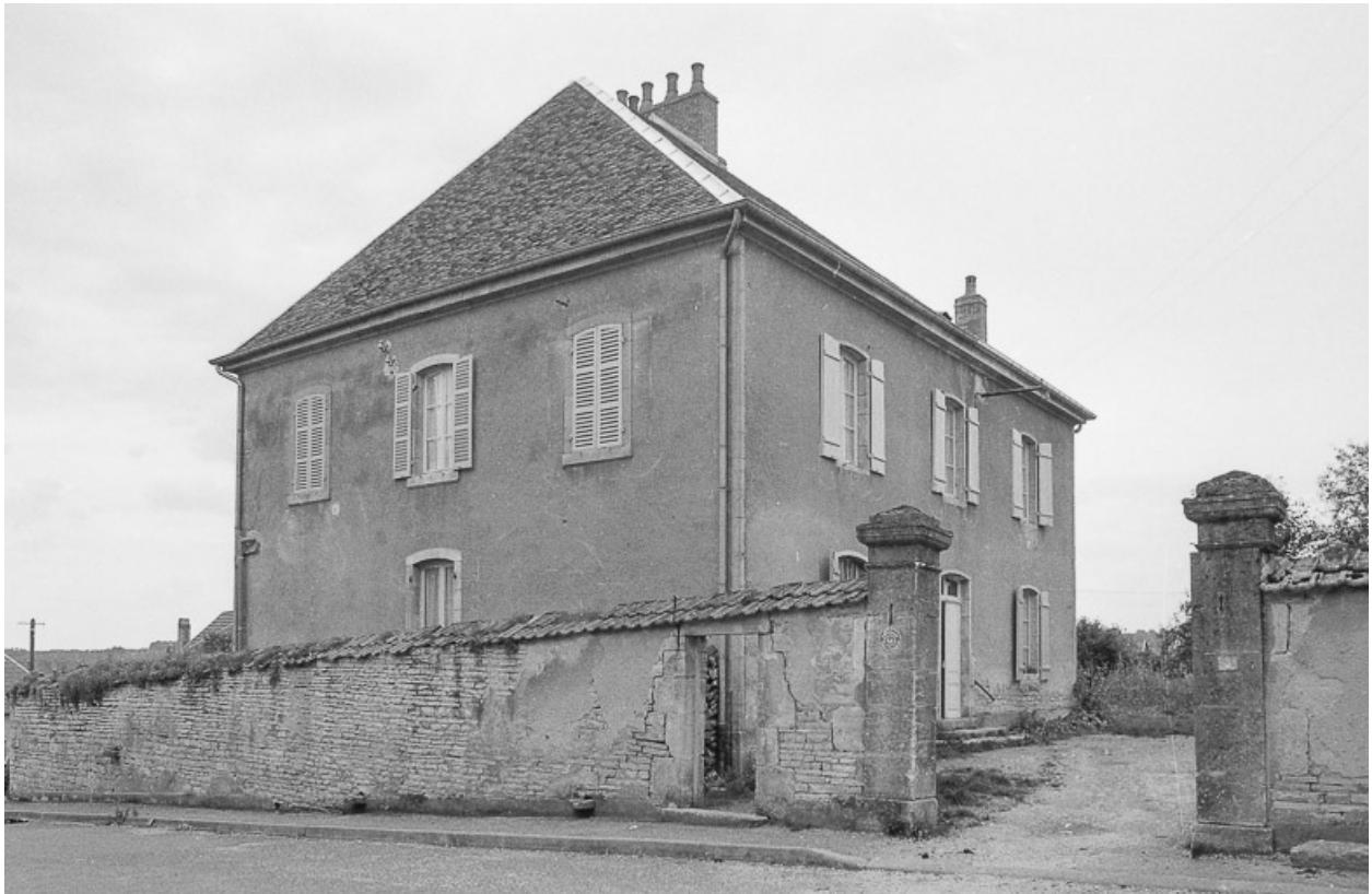
Façade sur cour.
