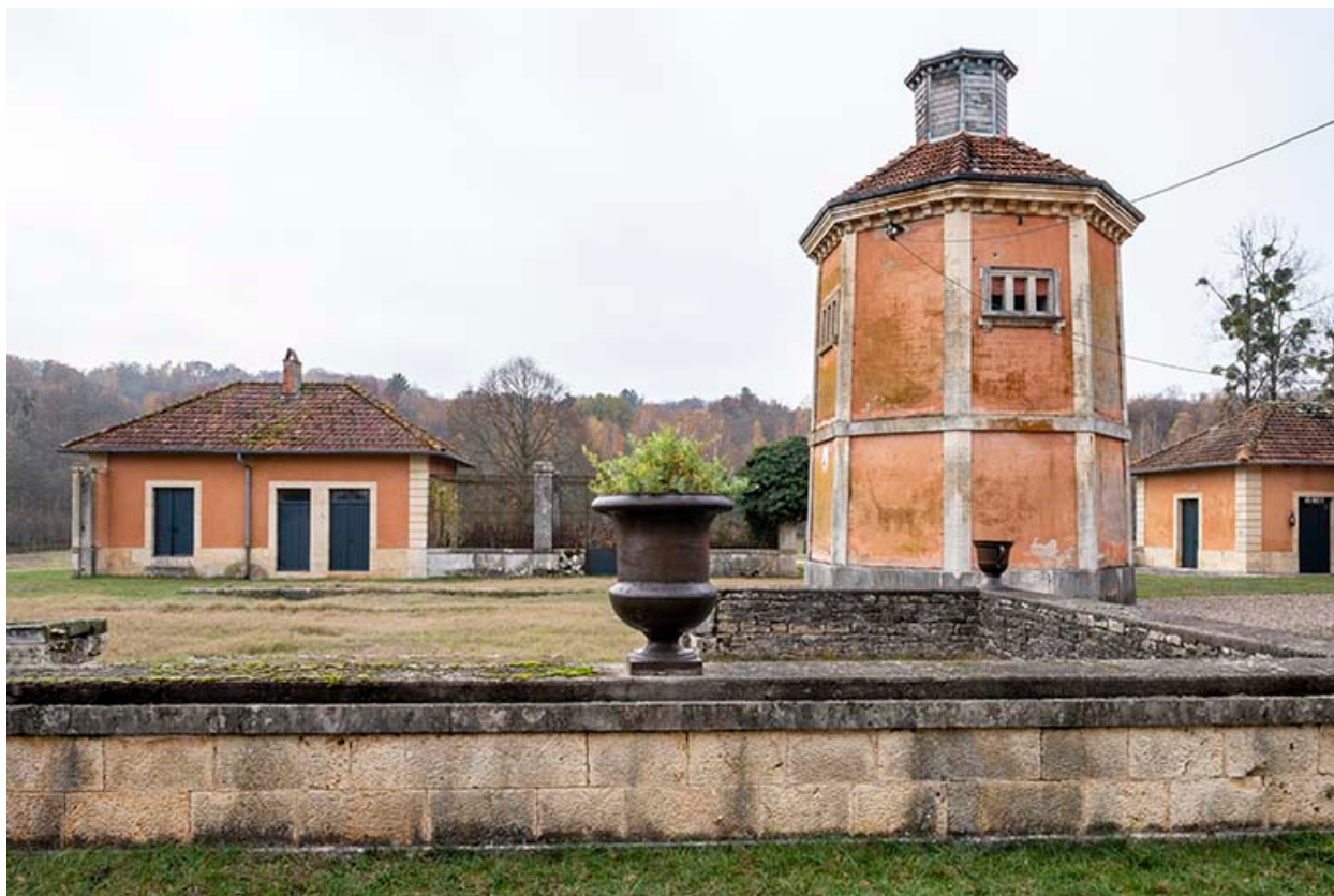
Pigeonnier, vue depuis l'est.
