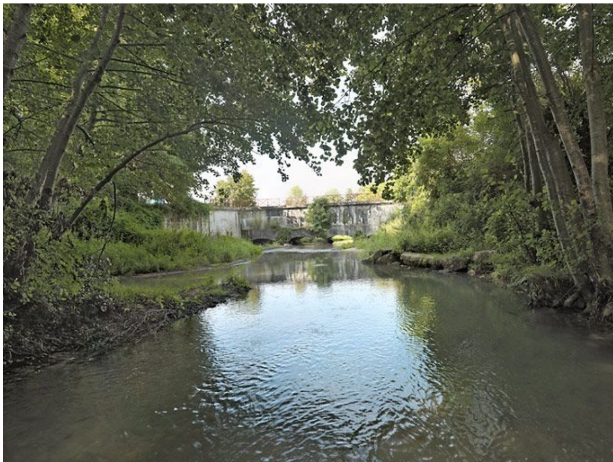
Le pont canal enjambant le Créanton.
