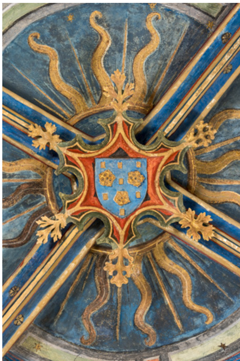
Clef de voûte de la travée occidentale.
