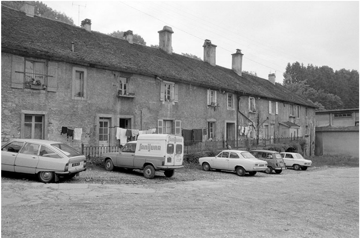
Logements d'ouvriers en 1980 : façade sur cour.
