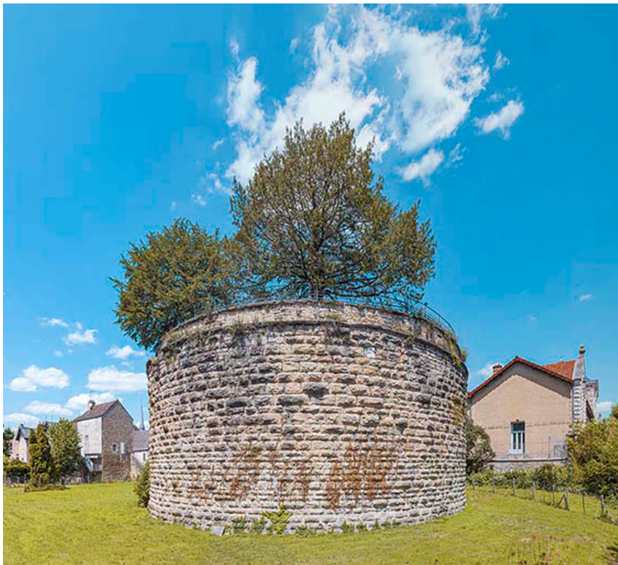
La tour depuis le fossé.
