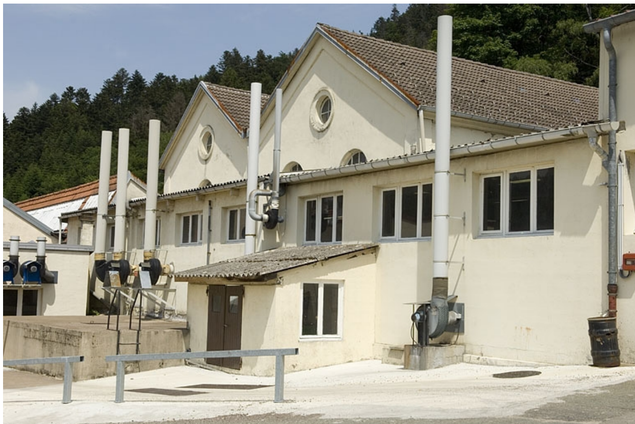
Anciennes chaufferie et salle des machines.
