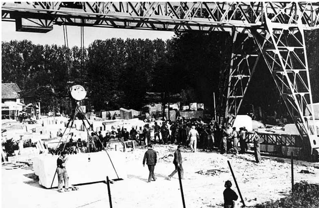
Vue d'ensemble le jour de l'inauguration. Photographie, 1957.
