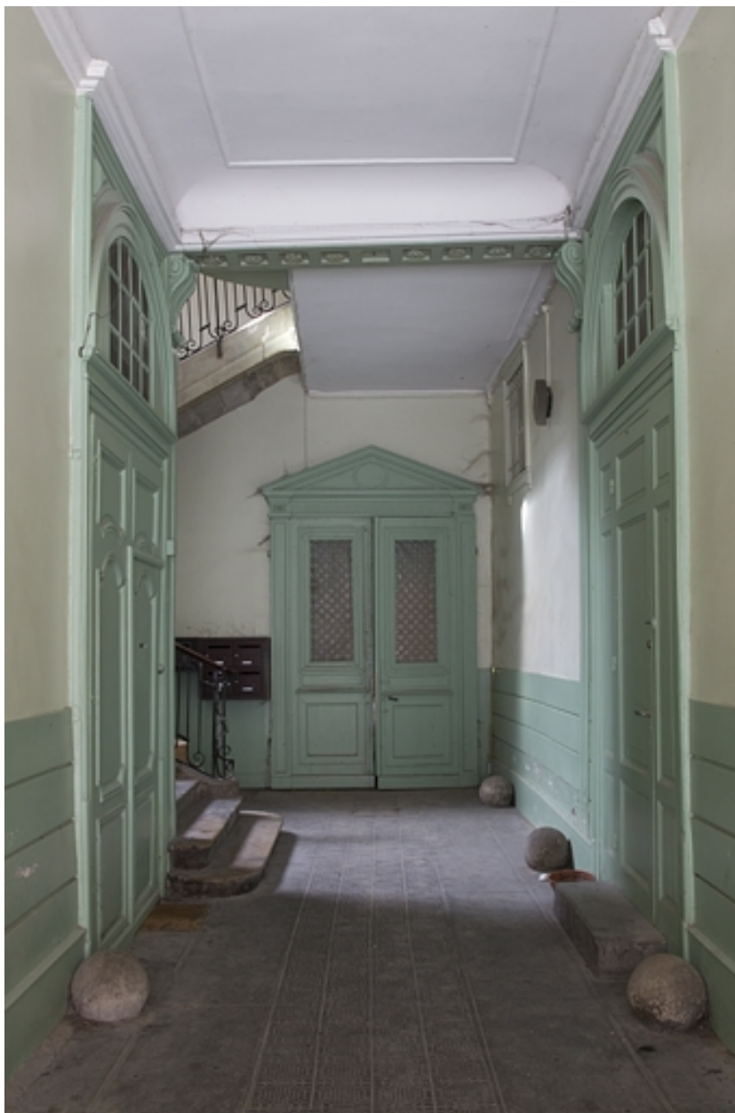
Intérieur : vue du passage cocher.
