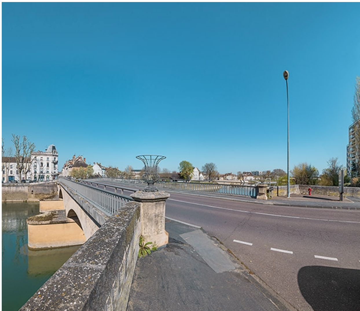
Vue d'ensemble du pont depuis la chaussée.
