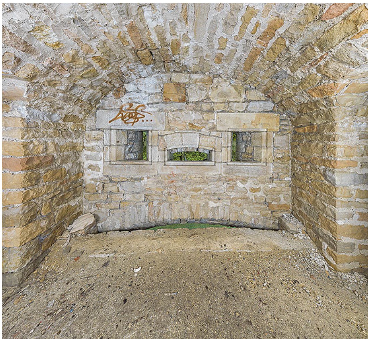
Créneaux de tir, double caponnière.
