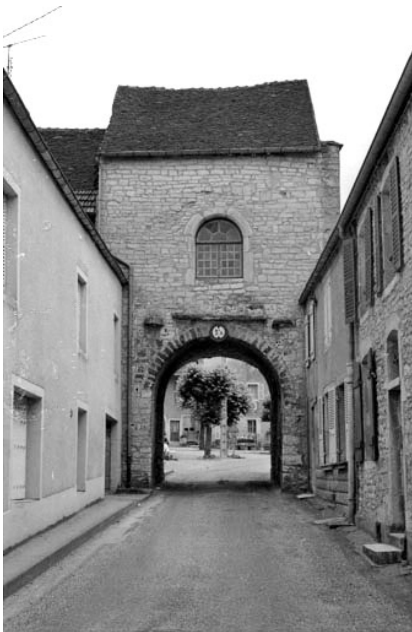
Porte Saint-Hilaire : façade extérieure.
