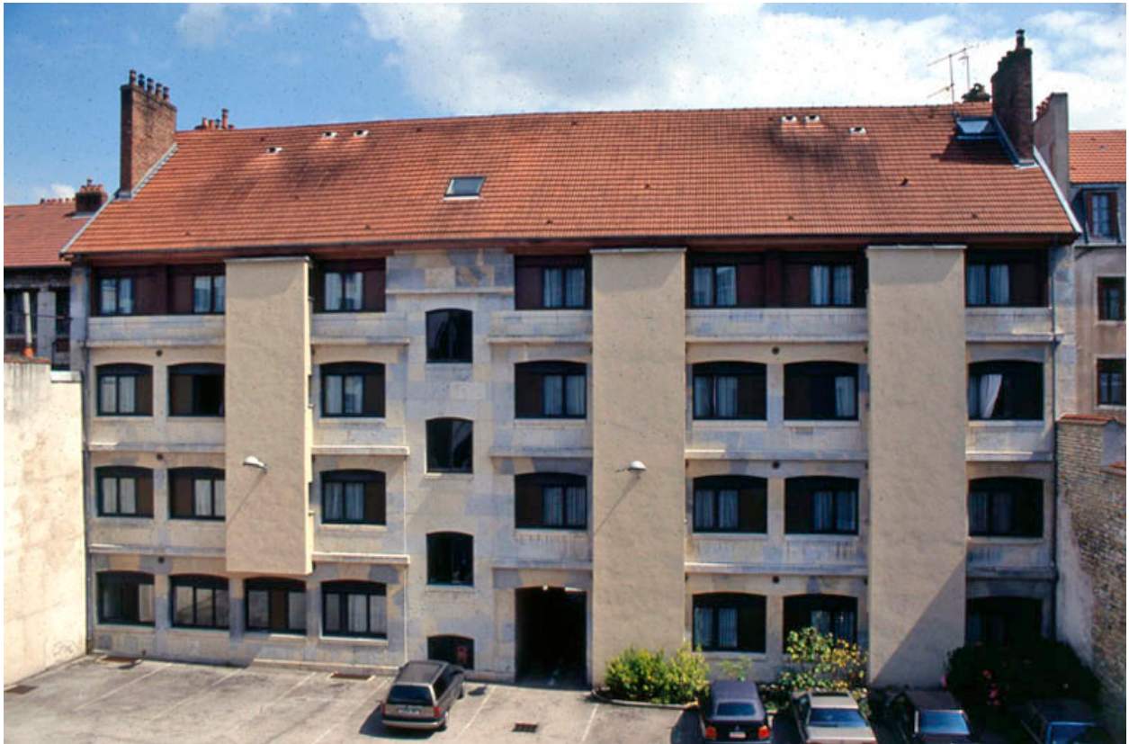
Façade postérieure en 1996.
