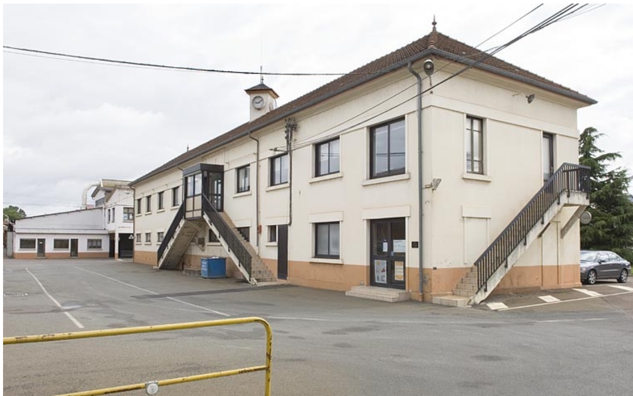
Bureaux. Vue de trois quarts arrière.
