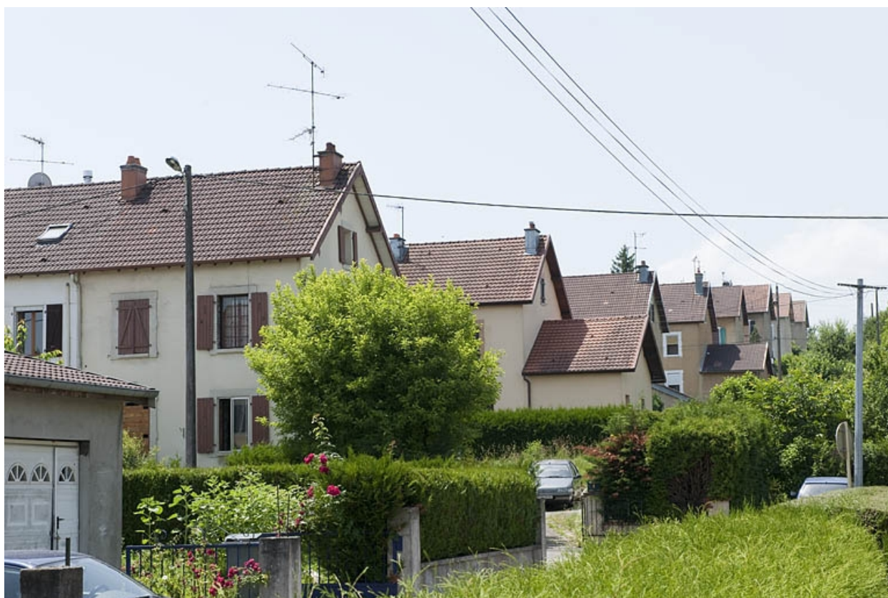
Pignons de maisons jumelées depuis le nord-est.
