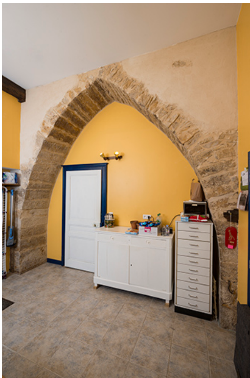
Voûte en tiers-point, arrière cuisine.
