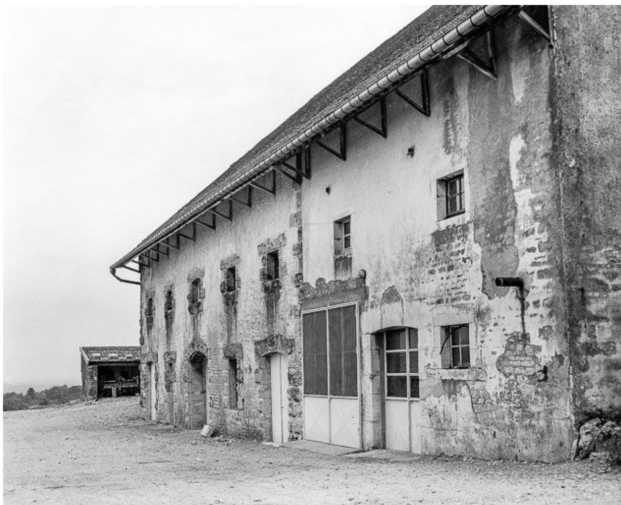
Partie agricole : façade postérieure.
