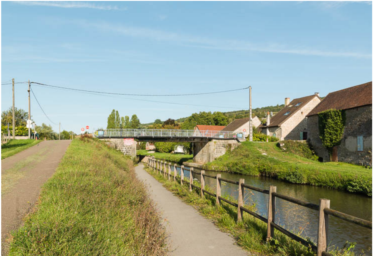
Vue d'ensemble du pont.
