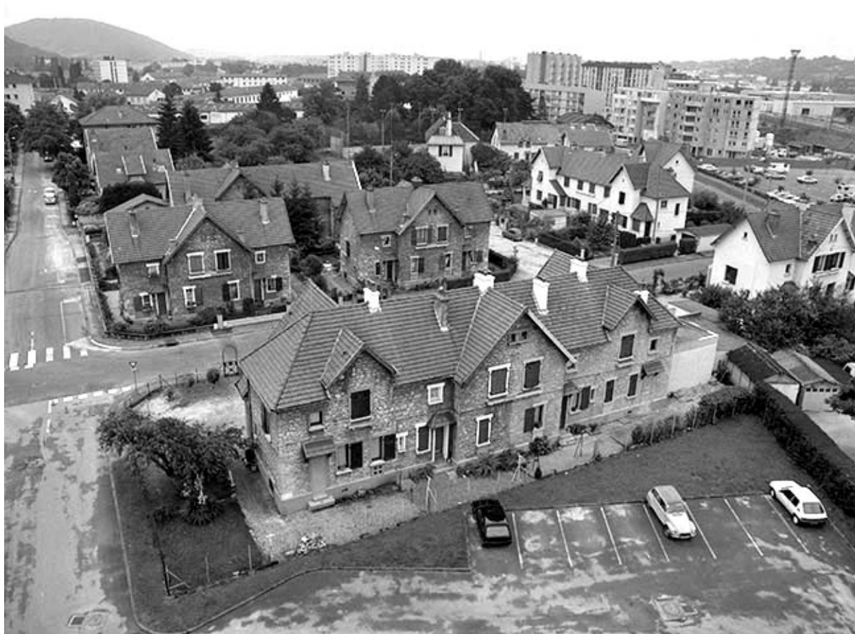
Vue d'ensemble de la cité ouvrière : sud-ouest.
