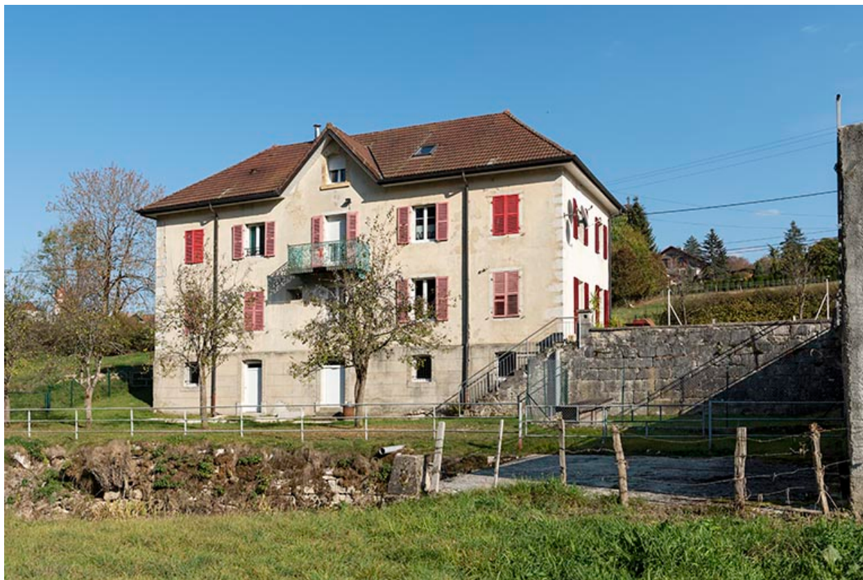
Maison : façade postérieure.
