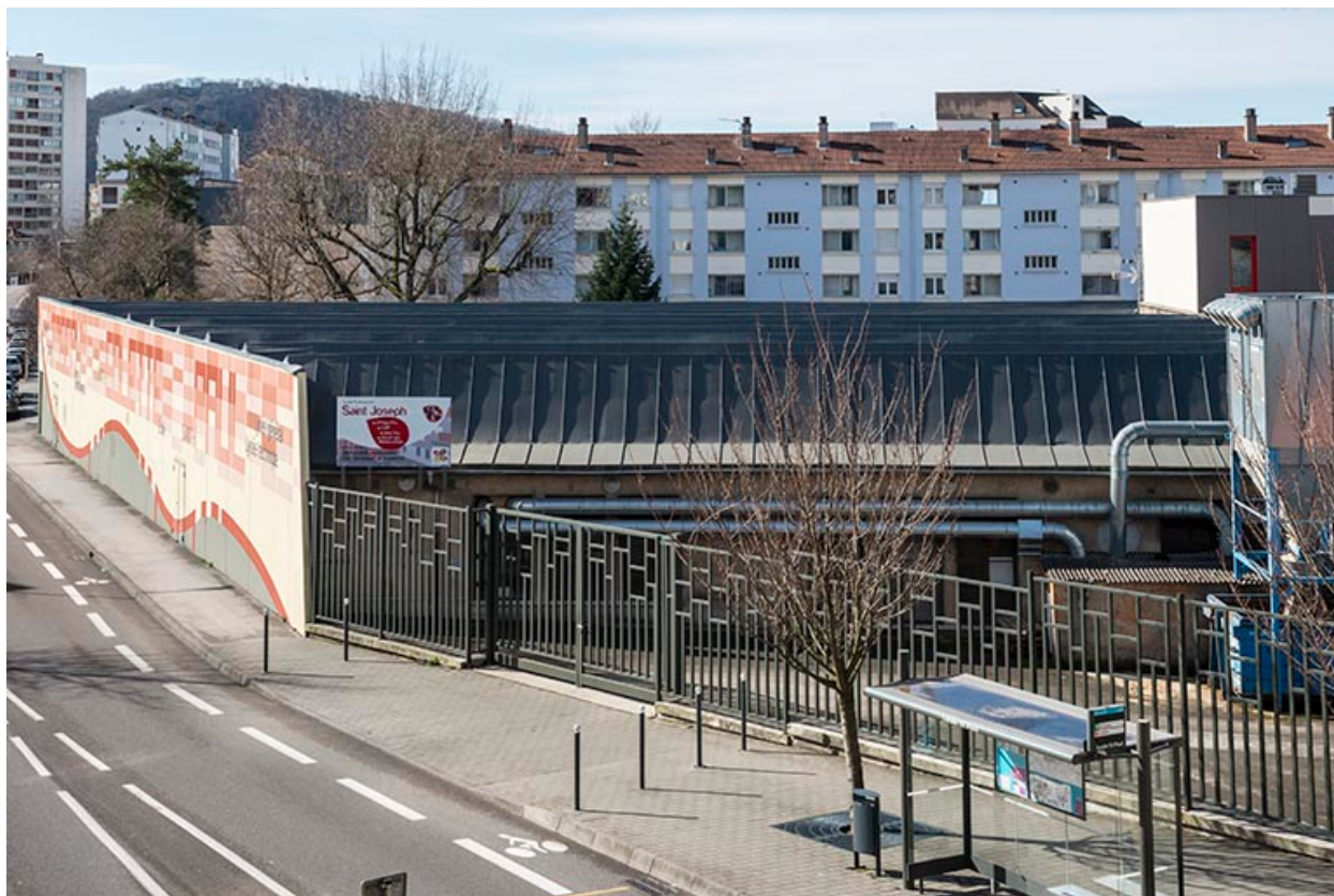
Atelier de l'usine automobile, depuis le nord.
