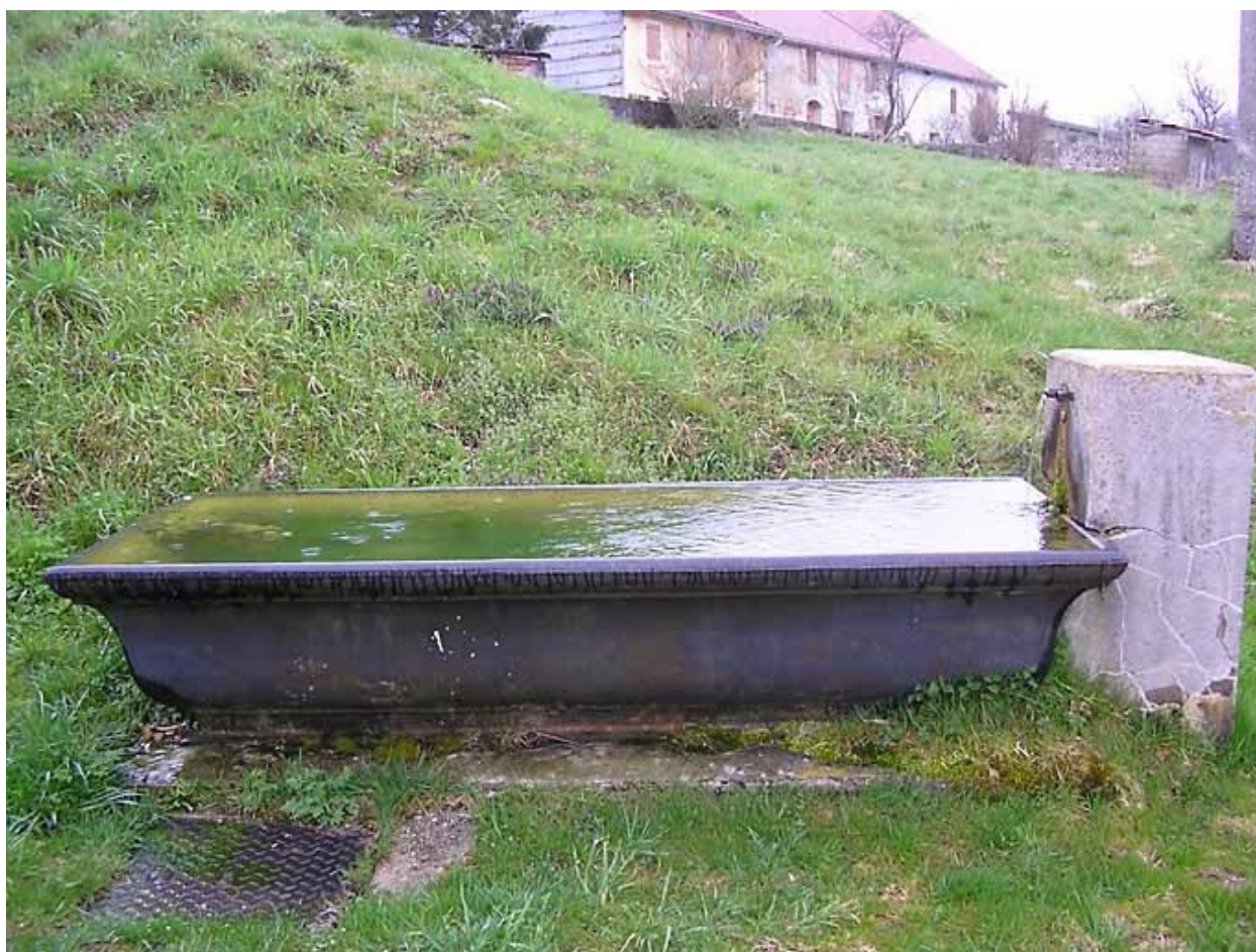
Vue sur l'ensemble hydraulique.
