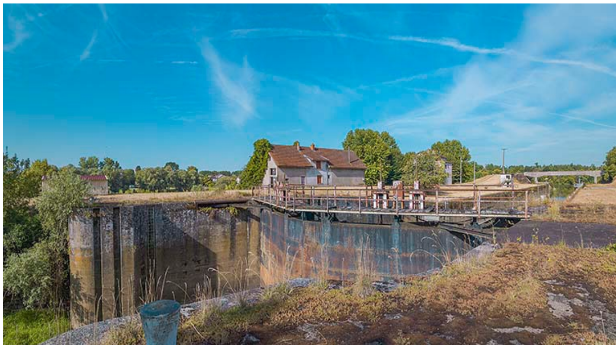
Les portes amont de l'ancienne écluse.
