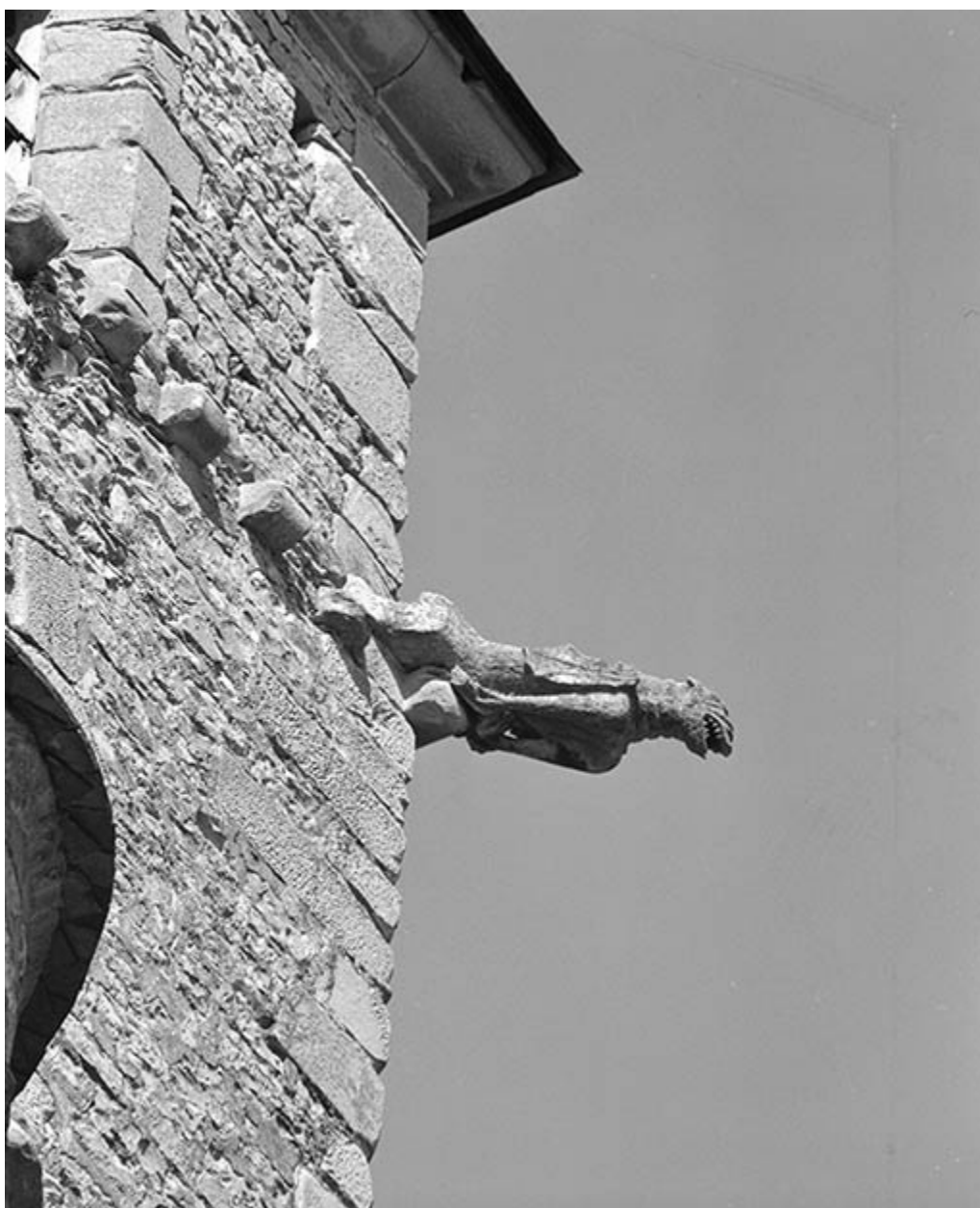
Façade droite du choeur, détail : gargouille droite.
