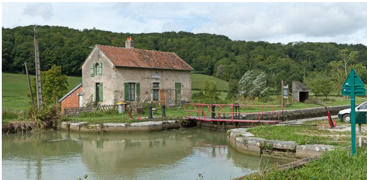
Vue du site d'écluse depuis l'amont.
