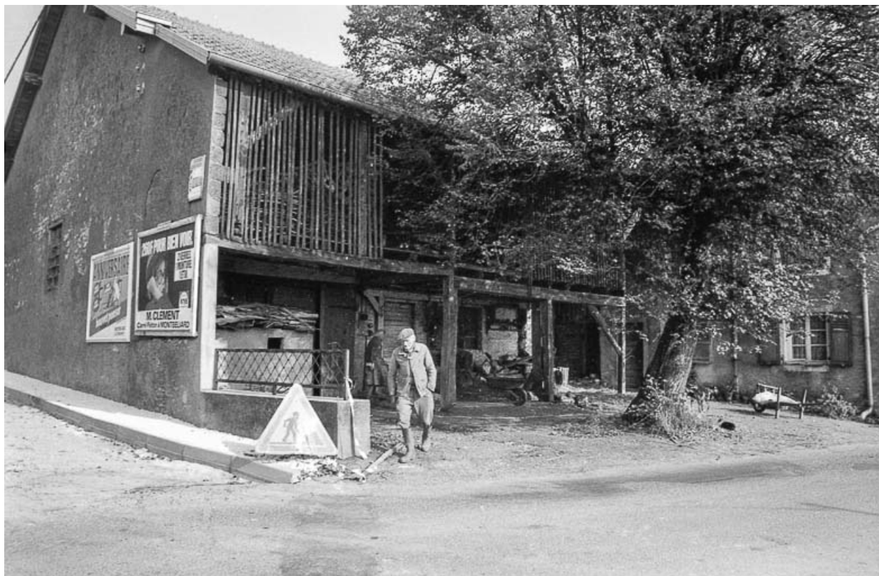
Façade antérieure : détail.
